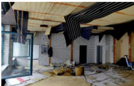
Vorbereiten der Innenräume auf den Abbruch. Entfernen von Böden und Isoliermaterial etc.
