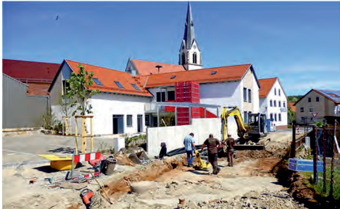
Straßenbauarbeiten im Bereich der Ebersbacher Straße
