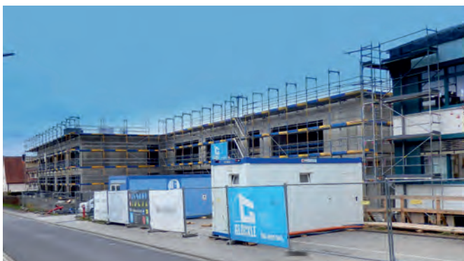
Ersatzneubau der Edmund-Grom Grund und Mittelschule. Auch im Haushalt 2020 der größte Investitionsposten.
