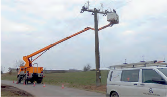
Wartungsarbeiten an einem Mast bei Leutershausen
