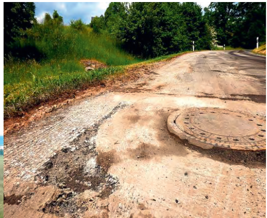
Abfräsen der oberen Asphaltschichten
