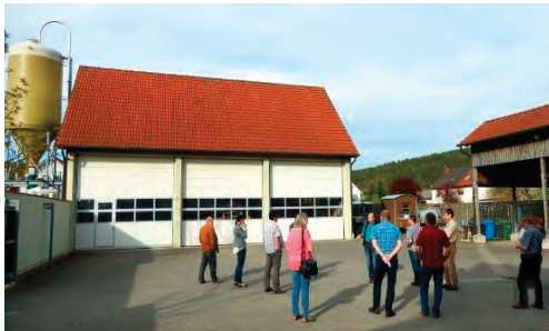
Maschinenhalle und Unterstellhalle der Bauhofgemeinschaft in Schönau a.d. Brend
