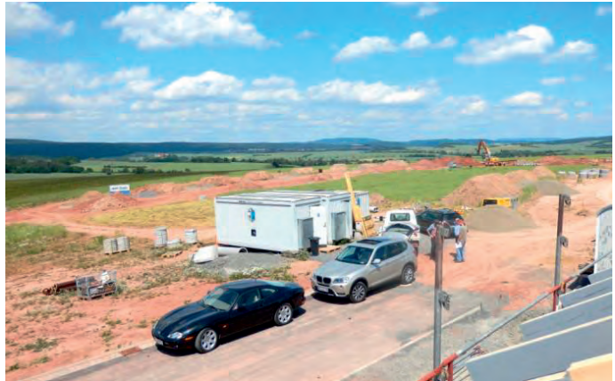
Blick auf die Erschließungsarbeiten im Baugebiet Landwehr BA II
