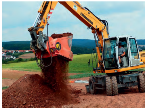
Bagger zerkleinert mit einem Separator den Rohboden
