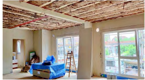
Der neue „Urbanussaal“ noch im Rohbaustadium.
