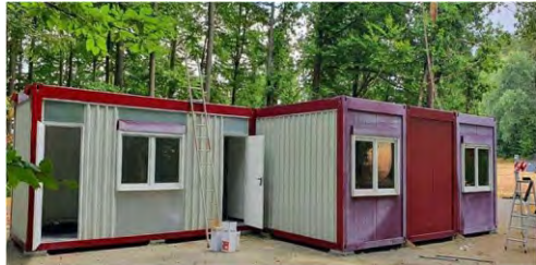
Der „Rohbau“ steht. Es fehlt noch das Dach und die Holzverkleidung.
