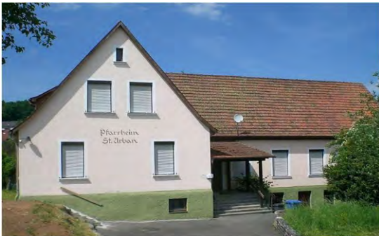
Das ehemalige Urbanusheim, Schwesternstation und Pfarrheim mit Pfarrsaal und Jugendräumen.
