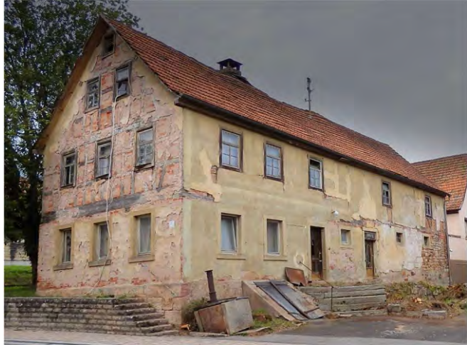
Das ehemalige Anwesen Johann-Klöhr-Str. 30. Erst nach dem Erwerb und Abruch des Hauses konnten die Planungen beginnen.
