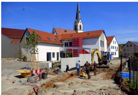
Fast fertig. Arbeiten am Gehweg und in der Ebersbacher Straße.
