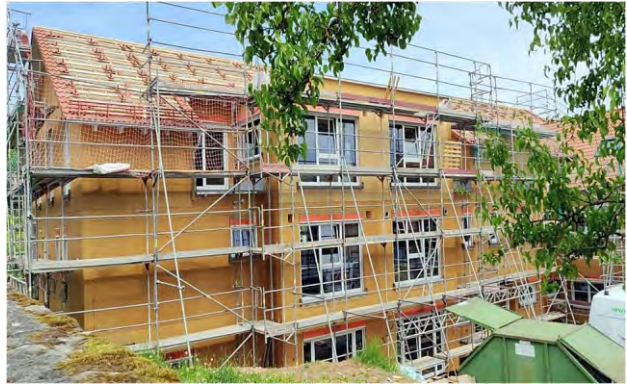
Nachhaltige und moderne Holzbauweise. Ein Markenzeichen der Fa. Albert-Haus.
