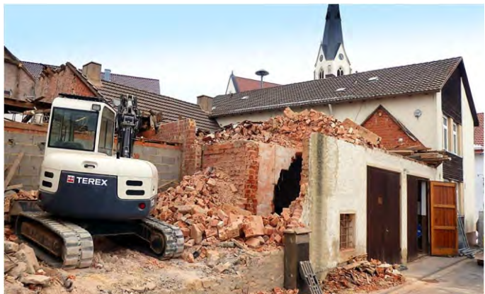
Abriss alter nicht mehr nutzbarer Gebäudeteile.
