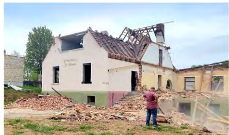
Der Abruch des Gebäudes war alternativlos.
