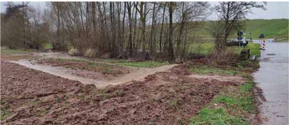
Die Rückführung des Überlaufwassers am Biberdamm funktioniert. Hier muss aber noch nachgebessert werden, damit der Acker nicht mehr überflutet wird.
