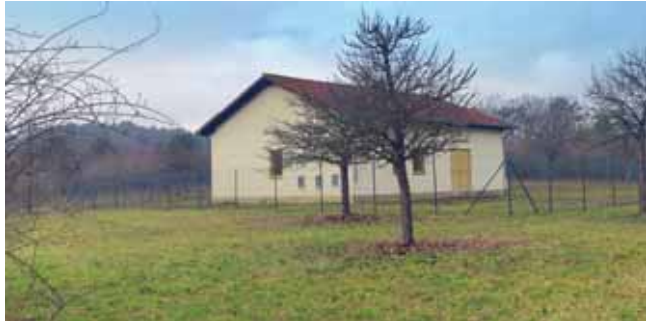
Maschinenhaus der gemeindlichen Wasserversorgung bei Leutershausen
