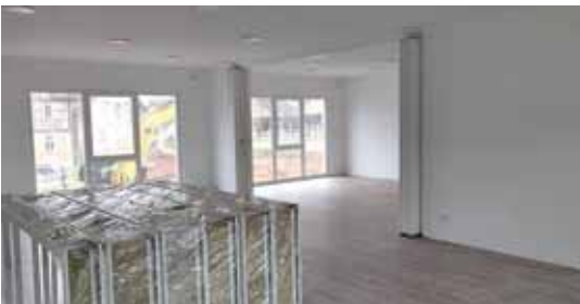
Blick in den „Urbanus-Saal“. Im Bild links unten stehen schon die Türrahmen für den Einbau bereit.
