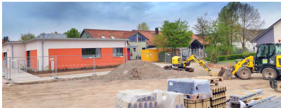
Derzeit immer noch eine Baustelle, der Parkplatz am Kindergarten in Windshausen.
