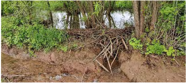
Dichtgemacht hat der Biber die Umgehungsgräben. Sie sollten die angrenzenden Flächen vor Überschwemmungen sichern.
