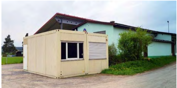
Zwei Container für den neuen Jugendraum stehen schon am Sportheim bereit. Wenn der dritte Container eingetroffen ist, kommen sie an den vorgesehenen Standort unterhalb des Hochbehälters von Leutershausen.
