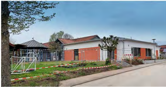
Ein wesentlicher Kostenfaktor im Haushalt 2023, der Kindergarten in Windhausen.
