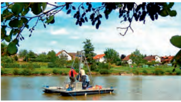
Rings um den Hohenröther See soll eine Begegnungsstätte für Jung und Alt mit Sport- u. Spielgeräten entstehen. Hier im Bild; Erkundungsbohrung im See.
