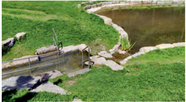
Gut gelungene Instandsetzung mit Wasserbausteinen.
