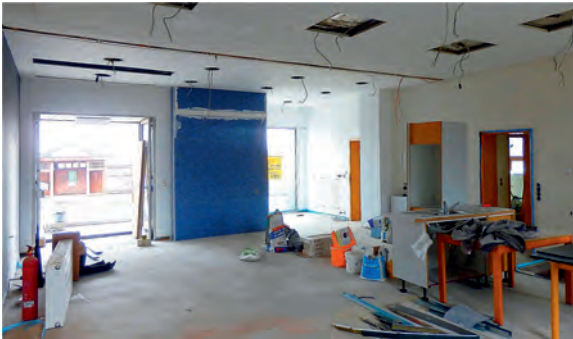
Blick vom Sitzungsraum zum Eingang. Hinter der blauen Wand befindet sich der Versorgungsraum für den Geldautomat. Die durchgehende Linie im Deckenbereich markiert den Verlauf der Trennwand zwischen Vorraum mit Zugang zum Bürgermeisterzimmer und dem großen Sitzungssaal.
