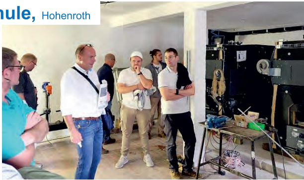
Der Gemeinderat besichtigte die neue Pellets-Heizung im Heizungskeller der Edmund-Grom-Schule (EGS)
