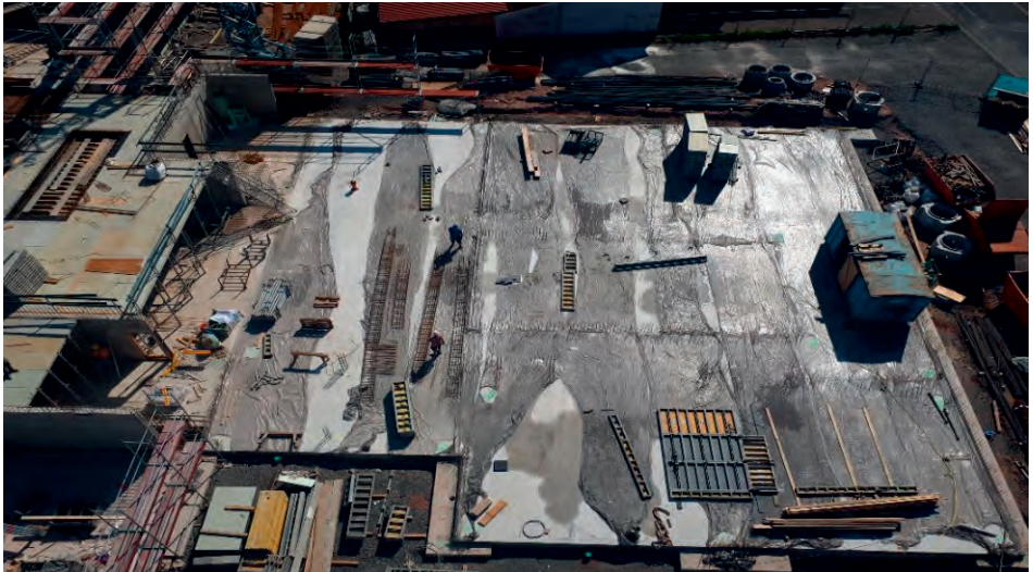
Die Bodenplatte ist fertiggestellt.
