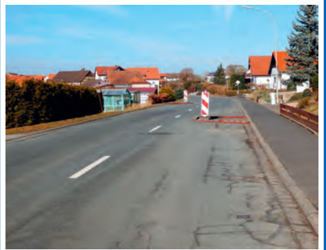
Hohenroth Seestraße: Deckensanierung Seestraße (Teilbereich 2015) 150 000 €
